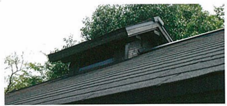
製作中「ハットひらめき」作った越屋根。内部には小さな換気扇がついていて、換気がよくなる
